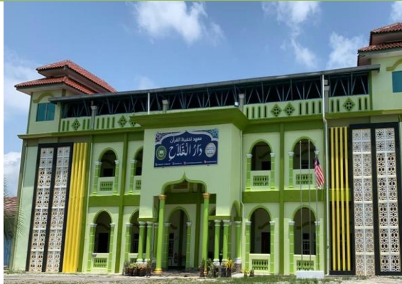
Gambar 1. Gedung Maahad Tahfiz Al-Qur'an Darul Falah Selangor Malaysia sebagai implementasi tangibles.
