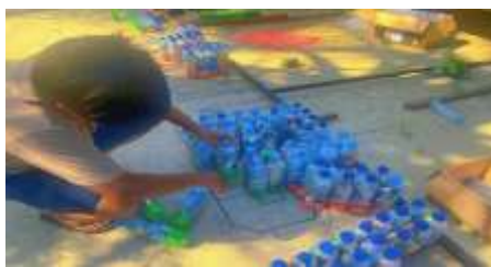
Gambar 1.4 Proses Penyusunan Botol Ecobrick ke dalam Rangka Besi Tuisan “Suak Merambai”
