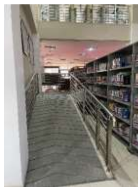
Gambar 4. Tangga yang dilengkapi dengan ramp
