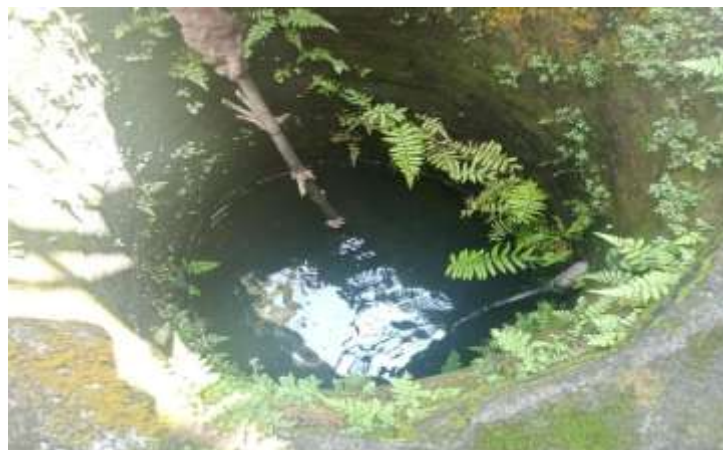
Gambar 3 Sumur Umum Di Dusun Krajan
