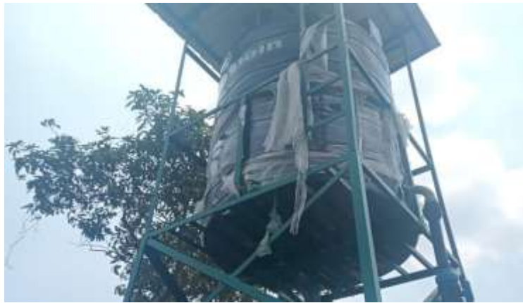
Gambar 4 Fasilitas tandon umum di Dusun Krajan sebagai penampungan air bantuan dari PDAM.
