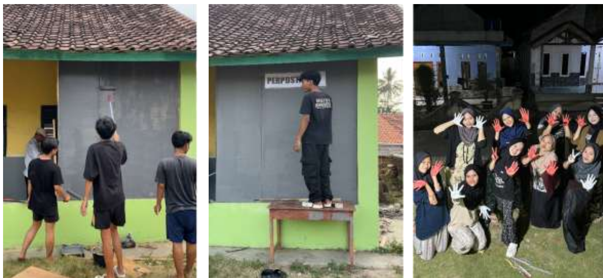
Gambar 1. Proses Pembangunan Perpustakaan Mini
