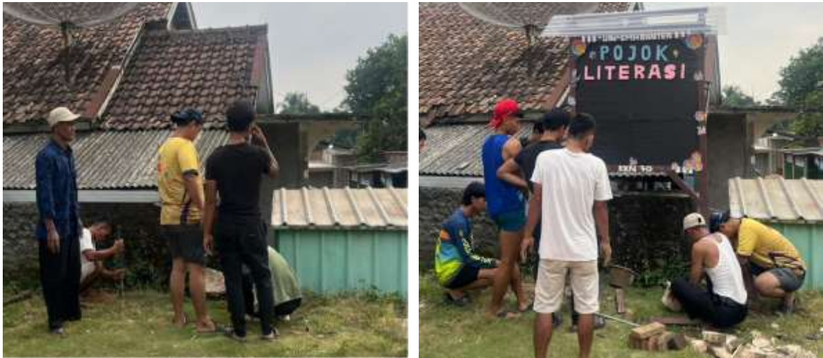
Gambar 2. Proses Pemasangan Mading
